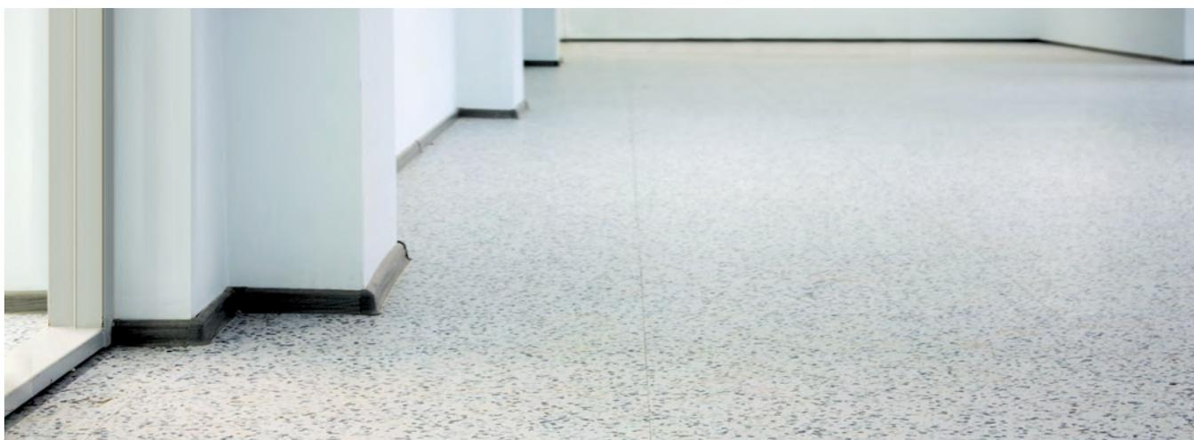
Линолеум VKG Linostat 608P специально разработан для помещений, защищенных от электростатических разрядов, в которых необходимо одновременное соответствие следующим требованиям:
